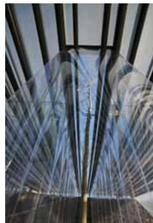
Le nouveau pavillon vient se situer au-dessous du niveau de la cote naturelle du terrain. Les grands murs soutiennent la structure en tubes circulaires disposés parallèlement. La couverture transparente en ETFE est constituée d'une double membrane précontrainte
