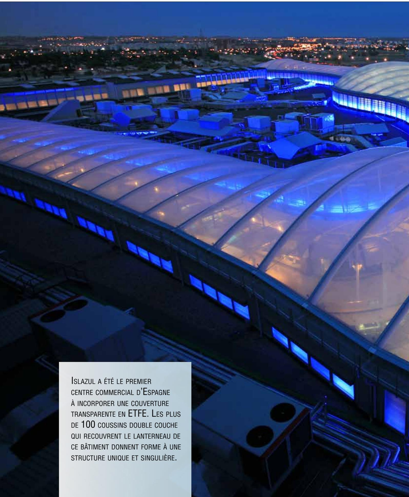
ISLAZUL A ÉTÉ LE PREMIER CENTRE COMMERCIAL D'ESPAGNE À INCORPORER UNE COUVERTURE TRANSPARENTE EN ETFE. LES PLUS DE 100 COUSSINS DOUBLE COUCHE QUI RECOUVRENT LE LANTERNEAU DE CE BÂTIMENT DONNENT FORME À UNE STRUCTURE UNIQUE ET SINGULIÈRE.
