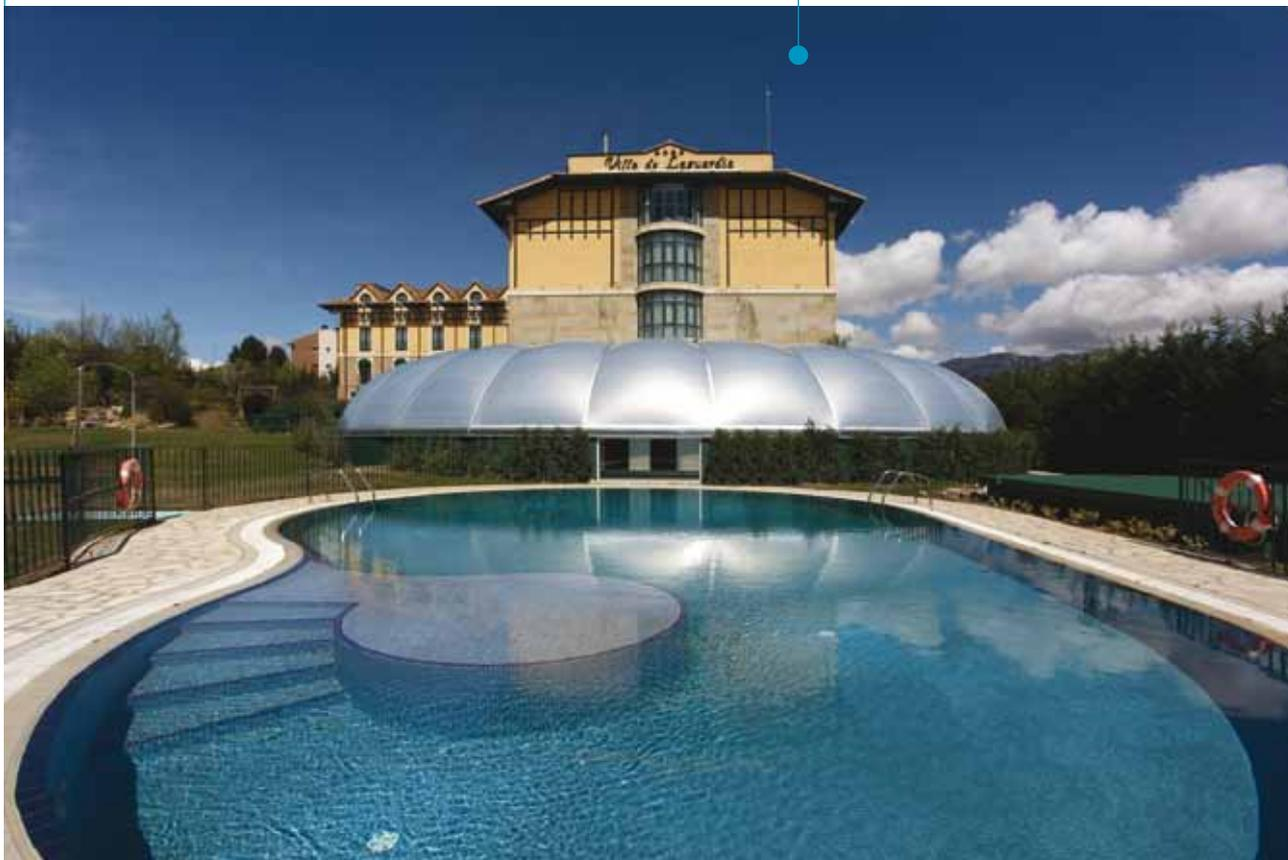
Le matériau ETFE employé pour la couverture semi-circulaire atténue l'entrée de lumière et la radiation solaire grâce la sérigraphie d'une de ses membranes.
