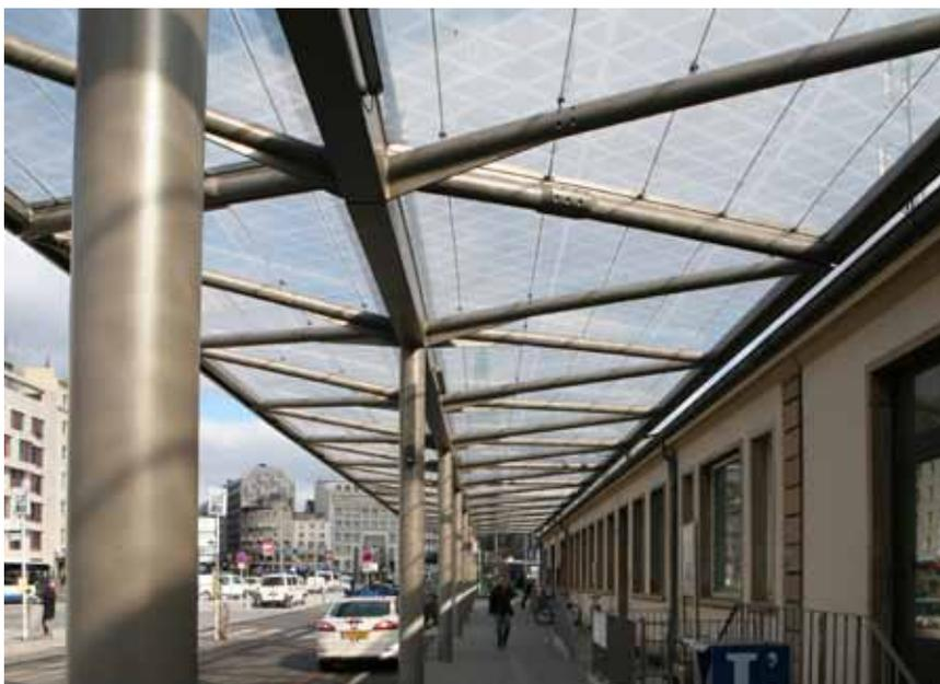
La nouvelle structure, créée à partir d'une géométrie en forme de losange, transmet une légèreté visuelle de grande beauté. Cet élément est également la base du design spécial avec lequel a été imprimée la membrane ETFE. La marquise pour piétons, en forme de couverture inversée à deux pentes, est longue de 117 m et large de 8 m.
