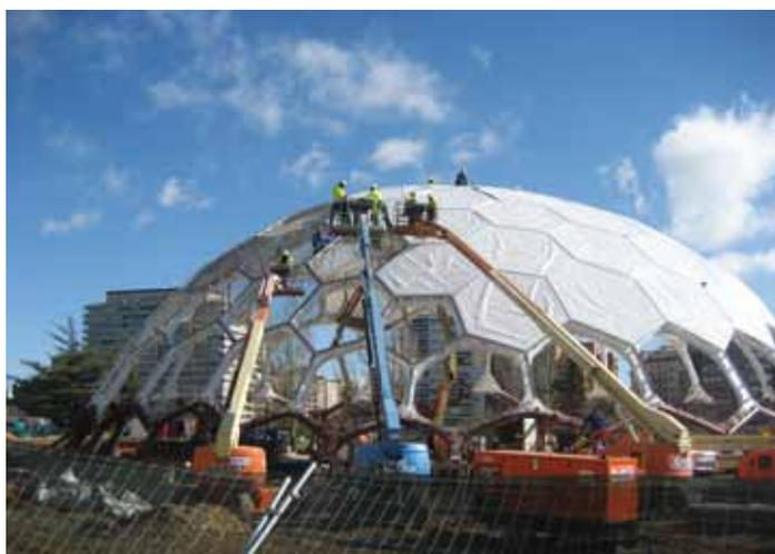
Le dôme est constitué d'une structure métallique en forme de calotte sphérique, de 45 m de diamètre, composée de polygones de diverses dimensions. Plus de 84 coussins triple couche sont disposés sur cette structure. Avec deux membranes sérigraphiées et une de couleur blanche. La transition de la couverture avec le sol se fait à partir d'un jardin vertical qui est interrompu par les portes d'accès au bâtiment.
