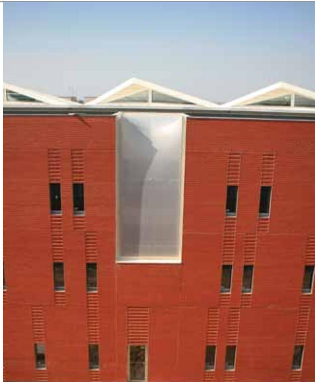
Les deux passerelles métalliques revêtues d'ETFE viennent s'appuyer entre les façades intérieures. Elles sont longues de plus de 18 m et hautes de 8,5 m. L'enveloppe transparente permet la ventilation naturelle grâce aux ouvertures supérieures de forme elliptique.
