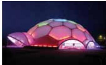
La membrane sérigraphiée des coussins réduit la radiation solaire à l'intérieur du dôme.
