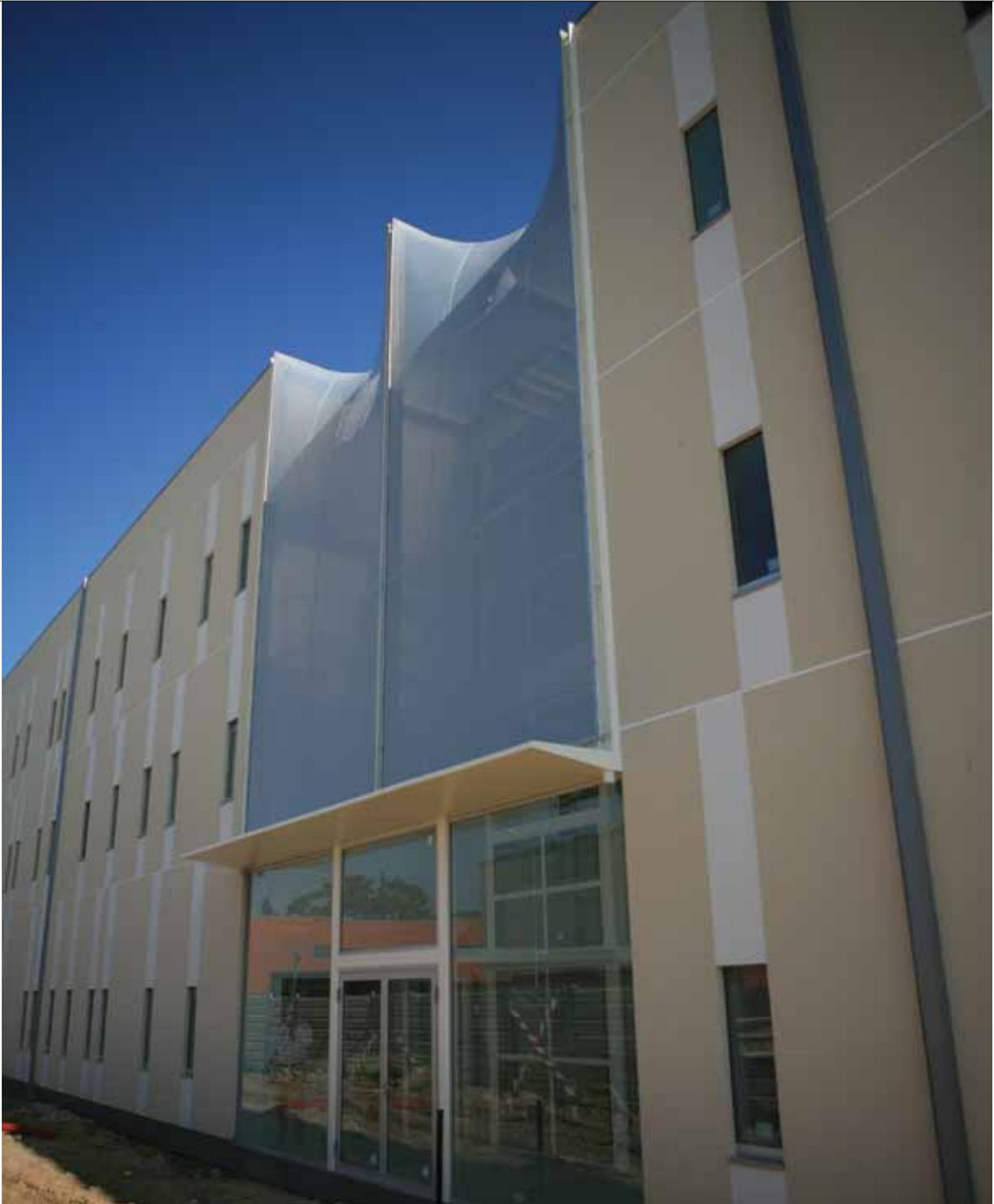
LA NOUVELLE ÉCOLE SUPÉRIEURE DE SANTÉ FAIT PARTIE DU CAMPUS DE L'UNIVERSITÉ D'AVEIRO. L'ENSEMBLE EST CONSTITUÉ DE DEUX GRANDS PAVILLONS ALIGNÉS ET RELIÉS PAR DEUX PASSERELLES. LA CONSTRUCTION UTILISÉE POUR LES ÉDIFICES CONTRASTE AVEC LA LÉGÈRETÉ DES DEUX PONTS DE CONNEXION ET DES OUVERTURES DE LA FAÇADE CONSTRUITES AVEC DES FILMS EN ETFE.
