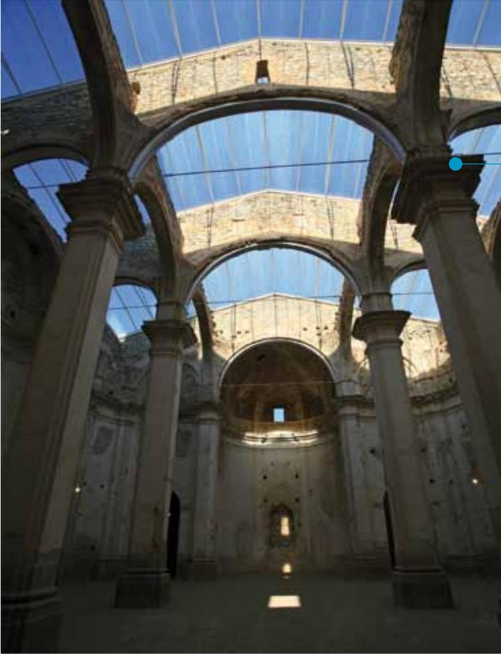
La transparence des membranes en ETFE fait que la nouvelle couverture disparaît visuellement et laisse apparaître l'édifice.
