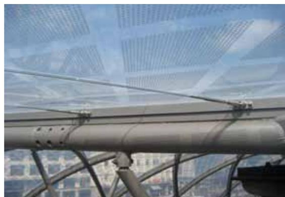
L'ETFE est un fluoropolymère fort, résistant et transparent. Il constitue une alternative aux matériaux conventionnels avaisée par des applications qui existent depuis plus de 25 ans.
