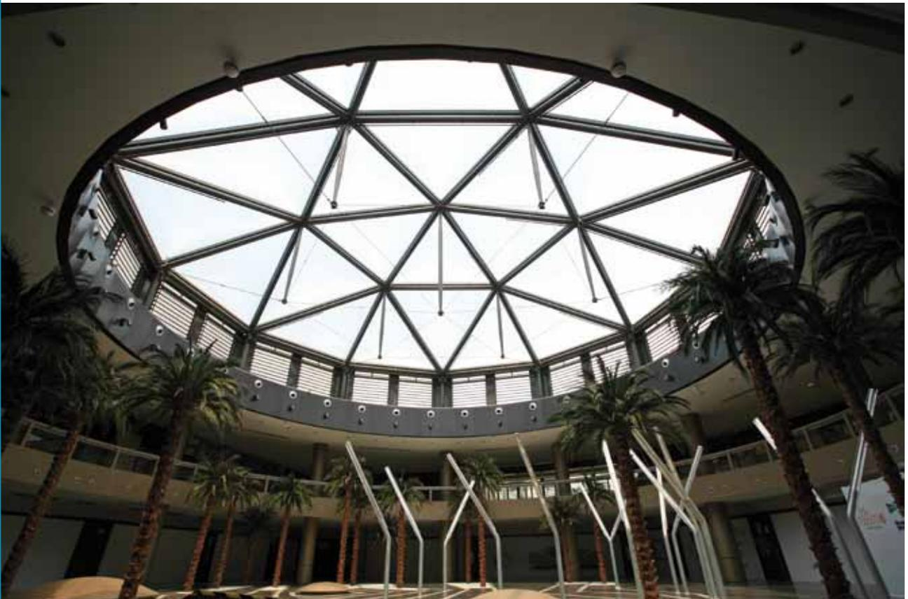
Sur la grande place où convergent les deux axes principaux de l'espace commercial apparaît le grand dôme de plus de 25 m de diamètre. La spectaculaire géométrie de la structure métallique décompose le lanterneau en 24 coussins de forme triangulaire. Les coussins double film imprimé protègent de la radiation solaire tout en laissant un passage très élevé de lumière visible.
