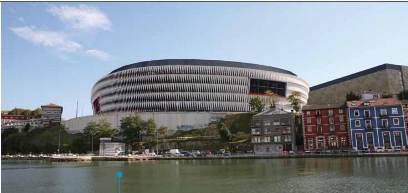
Depuis les diverses perspectives on observe un bâtiment dynamique, grâce aux membranes de 5,40 m sur 1,20 m, avec géométrie à double courbure.
