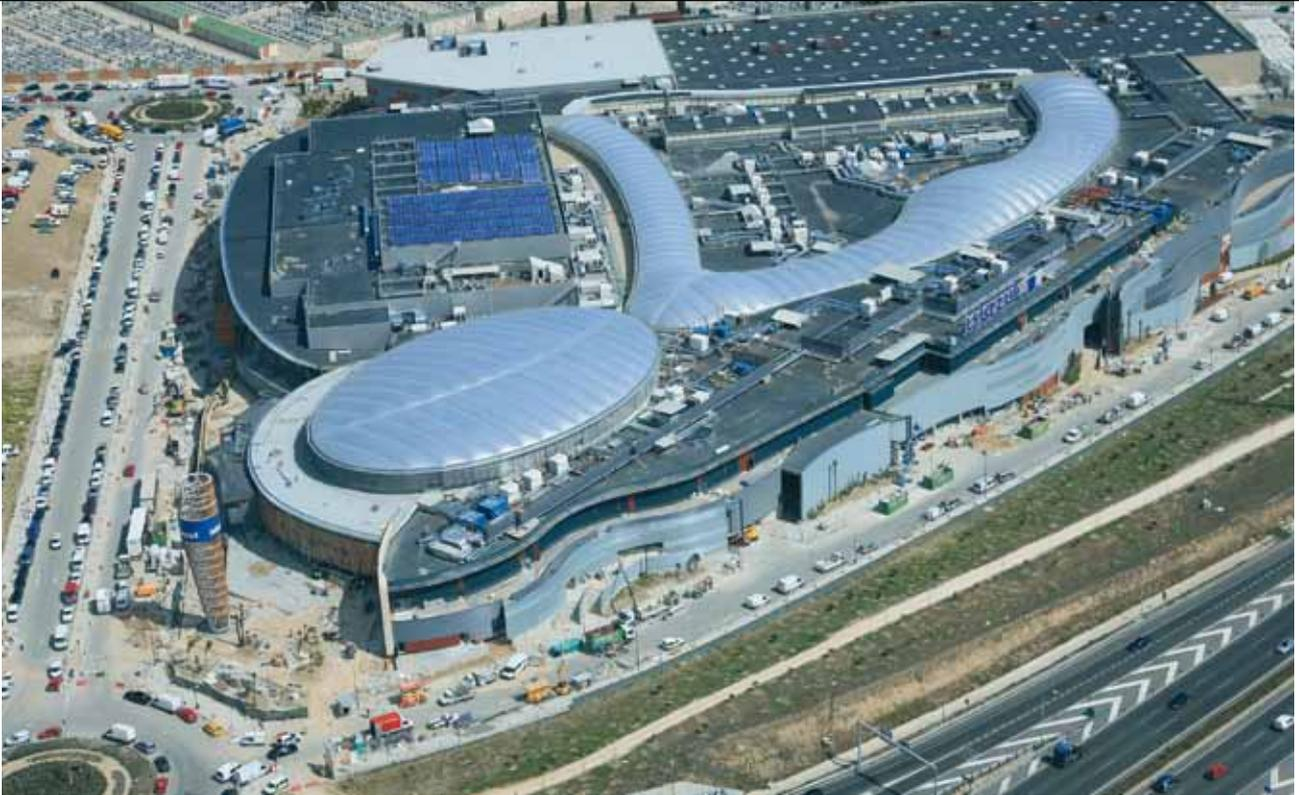
La place Caraba se distingue par sa forme elliptique et ses dimensions de 80 m de long sur 54 m de large. L'autre grand lanterneau se trouve sur la galerie commerciale, avec des coussins de 12 à 30m de long, pour 4,4m de large environ.
