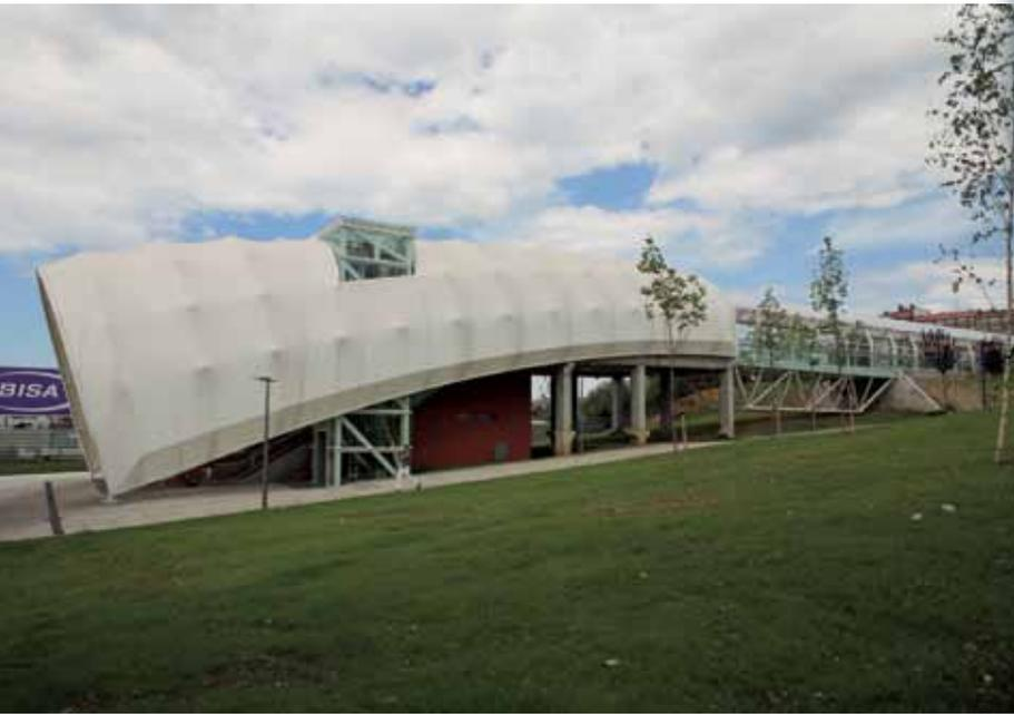
Un nuevo acceso para la estación de metro de Astrabudua, realizada con una solución de estructura metálica de nudos y barras y una cubierta textil. Siguiendo la geometría de los nudos, la lona se apoya sobre pequeños puntos que generan en la membrana pequeños conoides que se visualizan desde el exterior y dan la singularidad a esta envolvente.
