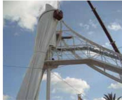
Cubrimiento de la piscina del Parque acuático Yamit 2000 a partir de una lona tensada de poliéster-PVC.
