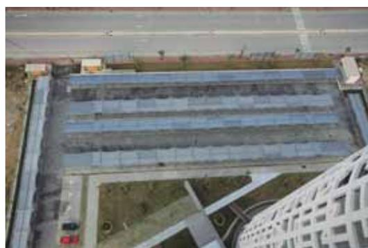
En este edificio tan emblemático se construye un aparcamiento exterior con una estructura metálica y una cubierta textil tipo rejilla para sombra. Los pórticos, situados a una distancia de 5m entre ellos, tienen inclinaciones distintas generando una cubierta con forma de ola.
