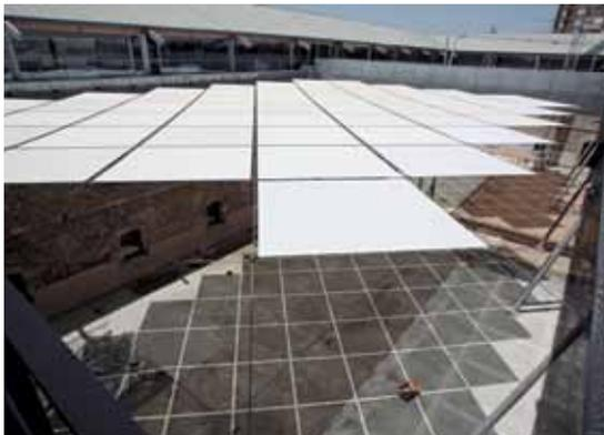
La rehabilitación de este antiguo cuartel ha permitido dar un nuevo uso a este edificio. En el patio central se forma una nueva estructura con dos pasarelas ortogonales que sirven para interconectar a los edificios y fijar la malla de cables para la protección solar.
