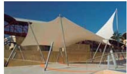
Las estructuras tensadas poseen una tecnología propia, basada principalmente en el comportamiento del material. La exigencia de una curvatura doble en toda la superficie de la membrana textil condiciona la forma de la misma y, por tanto, su aspecto final. La capacidad creadora y los conocimientos del proyectista, con la utilización sistemática de programas informáticos, son los que marcarán el resultado arquitectónico definitivo.
