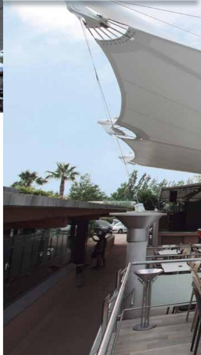
Muy cerca de una de las playas de la Costa Brava nos encontramos el Camping Les Dunes. Un complejo turístico con un área común, ampliada por esta nueva cubierta textil. Todo el conjunto nos recuerda a las embarcaciones que navegan en el mar, cables, botavaras, tejido. Destaca su gran pilar central inclinado de donde parten las barras radiales que estabilizadas por cables, permiten fijar los vértices exteriores de la membrana.
