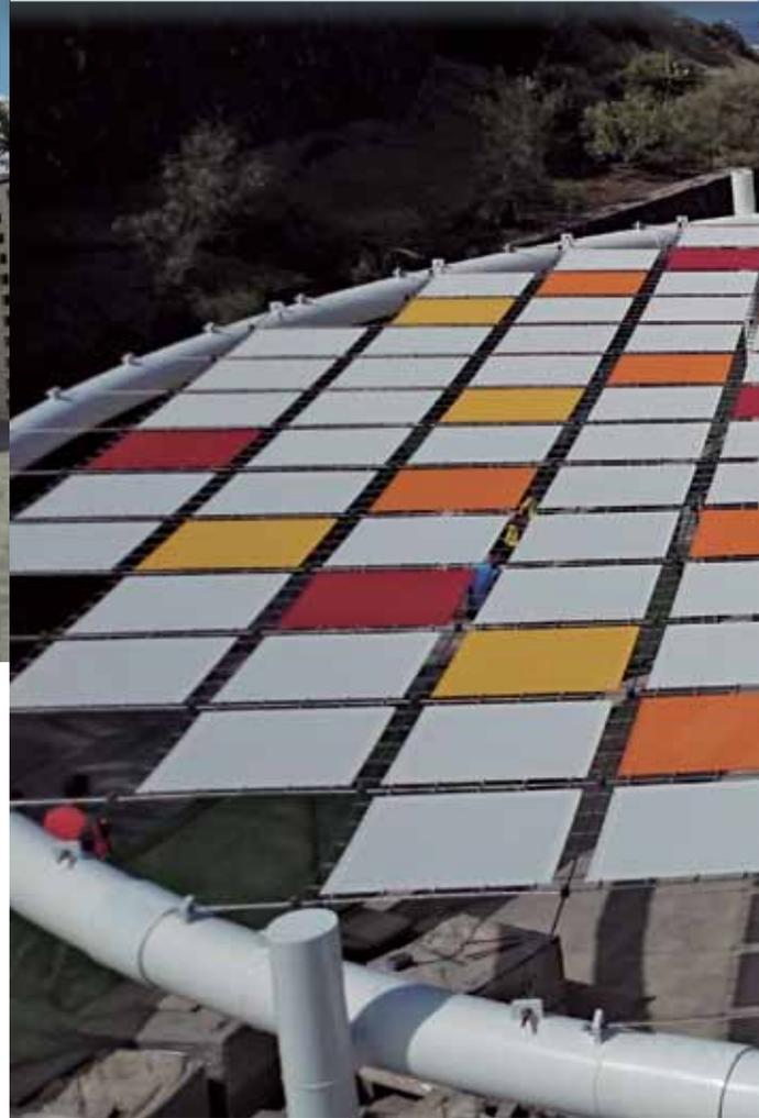
La mejora de la calle Unterhacing, del municipio de Adeje en la provincia de Tenerife, cuenta con el cubrimiento de tres zonas. Un total de tres estructuras circulares apoyadas en tres pilares con malla de cable que proporcionan sombra en esta calle peatonal. La cubierta de cada estructura está realizada con una malla de cables de acero inoxidable y lonas fijadas con muelles.
