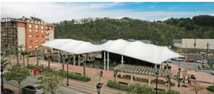
La nueva cubierta del municipio de Beasain, aporta la protección de lluvia y sol, a una área de juegos y un frontón. La membrana se apoya sobre arcos metálicos dispuestos oblicuamente y con alturas de pilares distintas.
