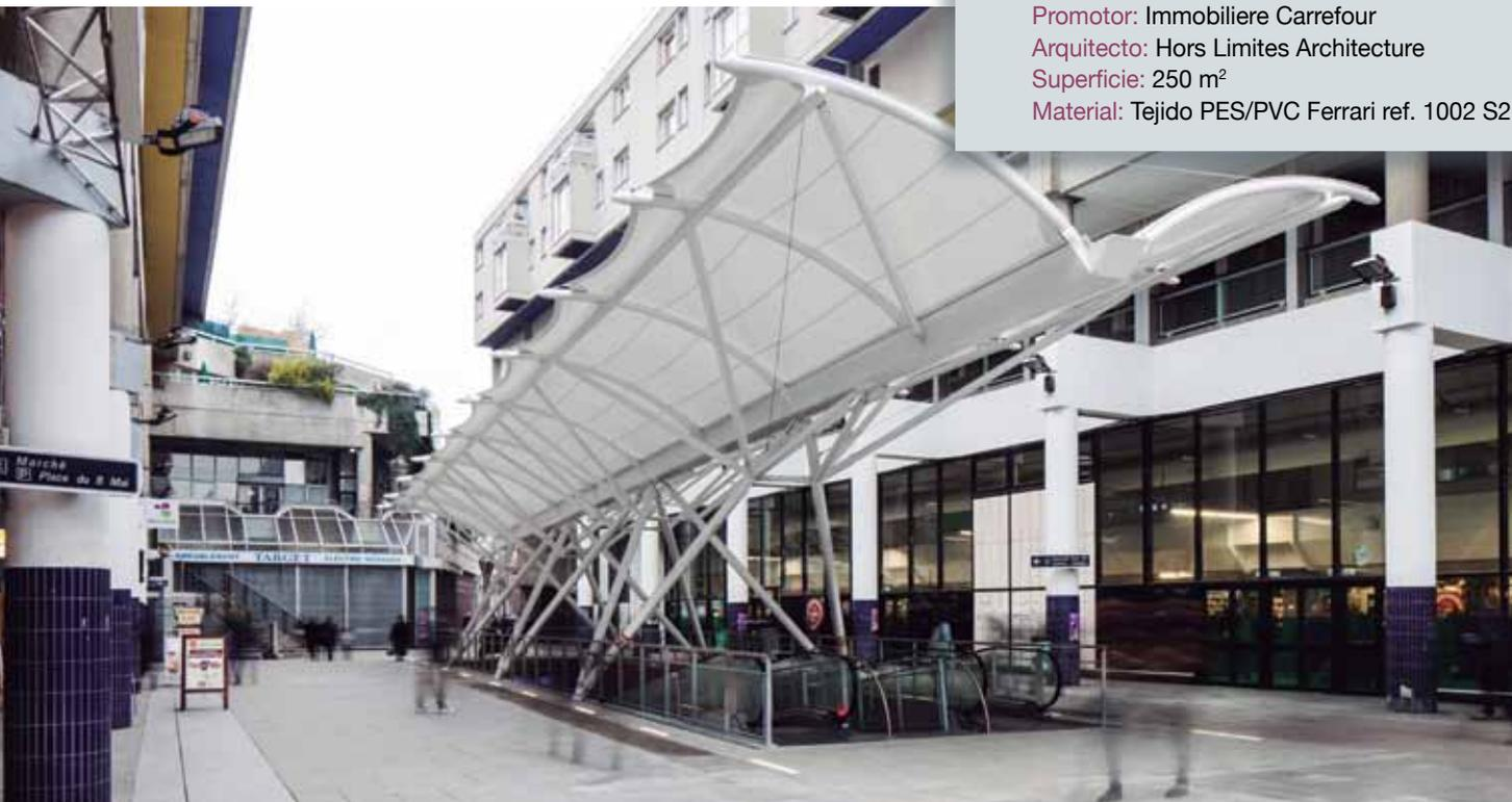
Una nueva cubierta se proyectó para la salida peatonal del aparcamiento subterráneo del centro comercial. La estructura se apoya sobre las dos líneas laterales del hueco en el pavimento y que permite la incorporación de las cintas mecánicas. La membrana textil, formada por dos piezas, sigue la forma de ala que describen los elementos metálicos.
