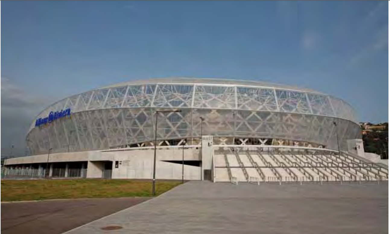
Nouvelle façade et ceinture intérieure construites avec des membranes en ETFE.
